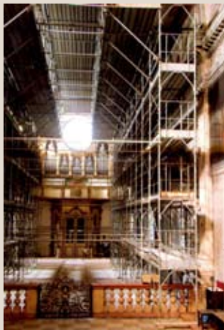
Alcune immagini di ambienti del Monastero di San Benedetto in Polirone soccorse con ponteggiature dopo il terremoto.
